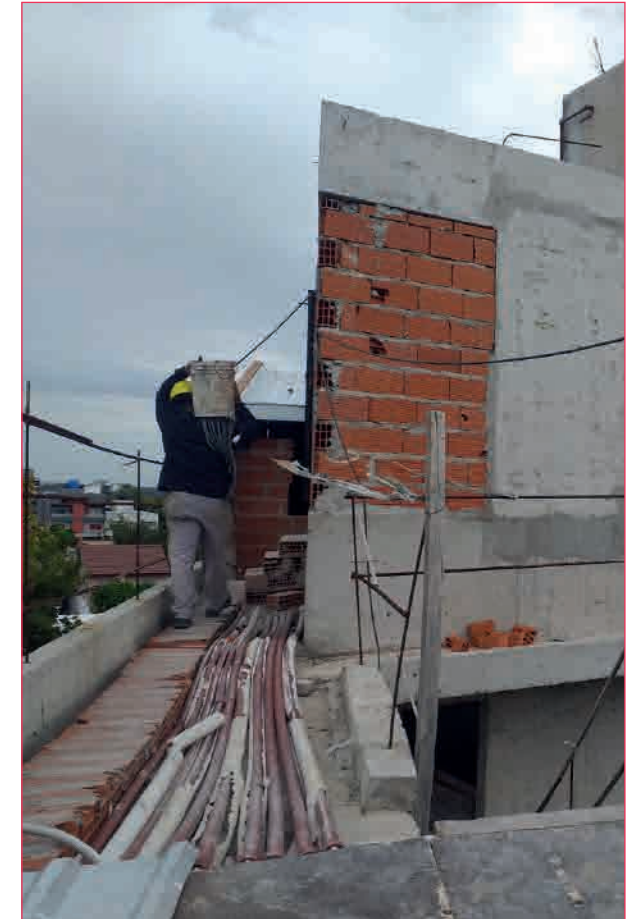
CONSTRUCCIÓN EDIFICIO CALLE BIARRITZ
